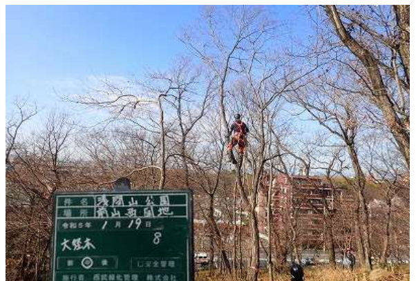
ロープを使っての高所作業（枝打ち）
