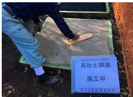
飛び石風土系舗装作業
