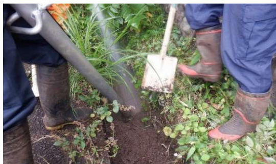
（土砂撤去作業）
