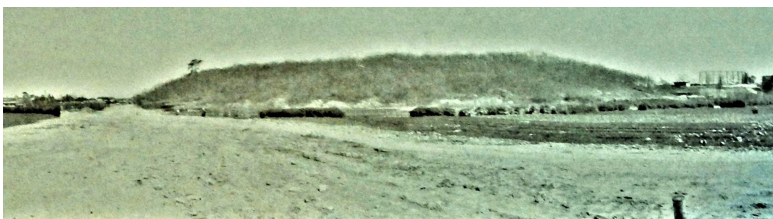
昭和 40 年代半ばの新小金井 街道建設中の頃の浅間山 この付近は人見原古戦場
