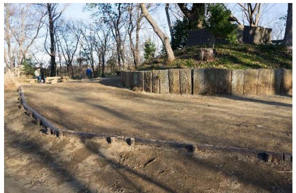
2024年12月堂山山頂の土盛り工事が完了しました
